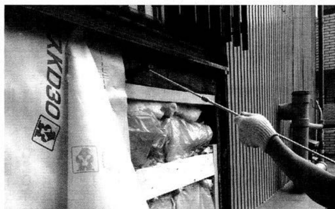
ホウ酸系防蟻剤の施工の様子(写真提供：日本ボレイト)
