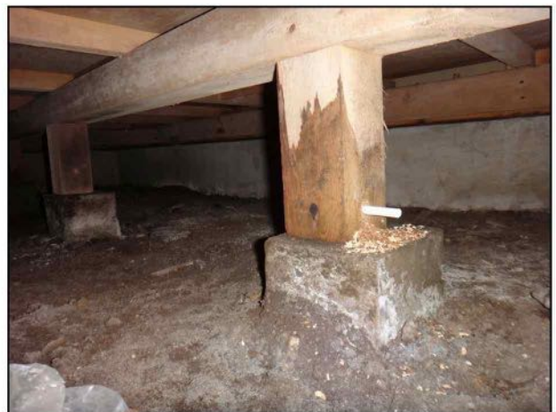
床下の束柱に。
