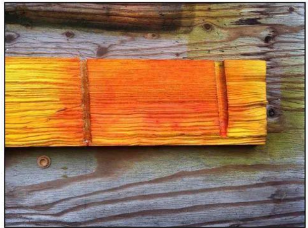
処理後6か月経過後の状況。 赤く発色している部位に DOT が拡散しています。
