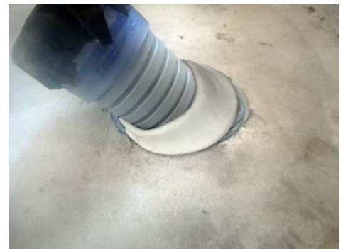
※さや管と排水管の隙間へ充填。
