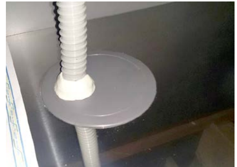
※キッチン排水管の隙間へ充填。
