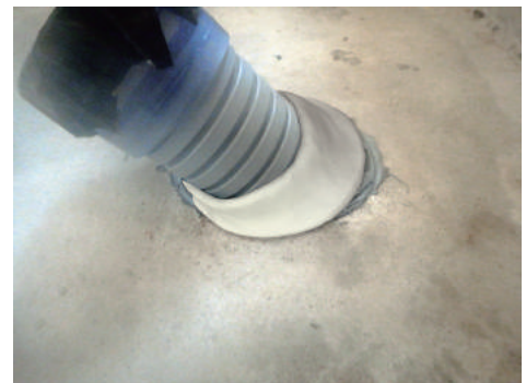
※さや管と排水管の隙間へ充填。
