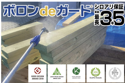
ホウ酸を木材に含浸させる「ボロン de ガード®」工法
