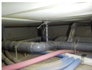
床下が十分に乾燥してから清掃を行う
