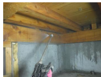
水害対応キットの施工イメージ
